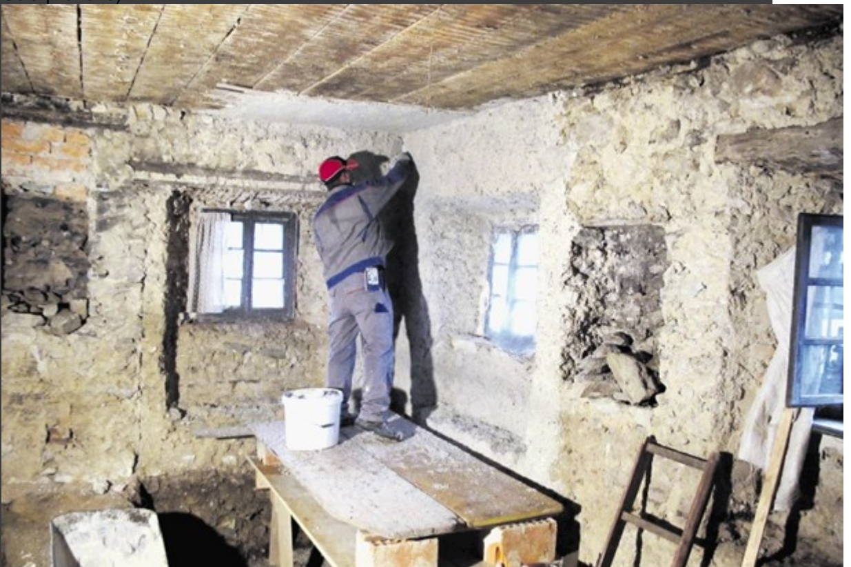
Udeleženci delavnice so apneni omet v Kvandrovi hiši v Mošnjah nanašali na različne podlage. (Foto: Šola prenove)
