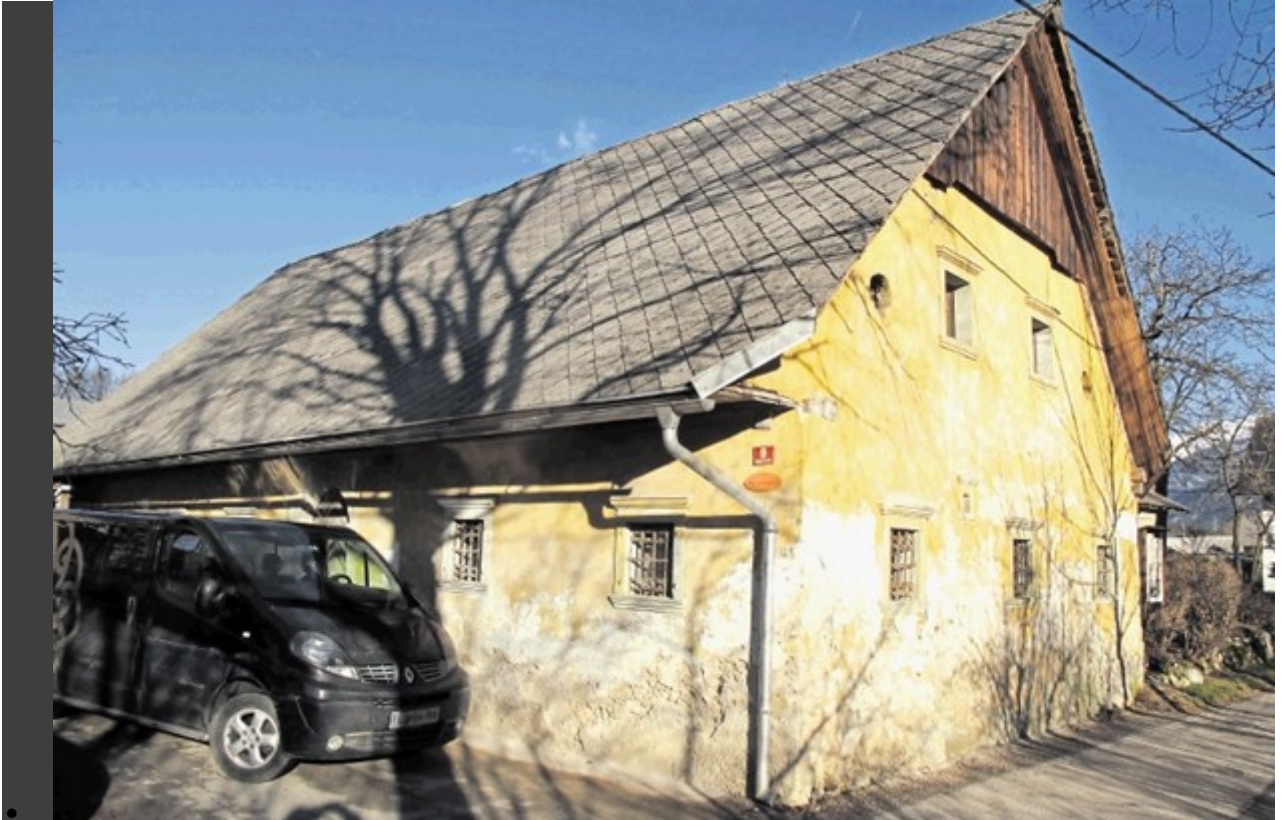
Zidarji bodo vse pogosteje prenavljali stare hiše, kakršna je Kvandrova v Mošnjah. (Foto: Šola prenove)
