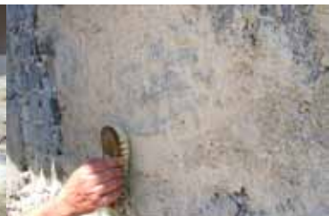
Proces začetnega nanašanja apnenega ometa.
