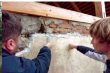
Utrjevanje podlage, čiščenje še uporabnega apnenega ometa in priprava stikov.
