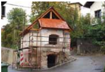
Začetek prenove ometa stare kašče. Predpogoj je bila kakovostno obnovljena streha objekta, ki je preprečevala zamakanje.
