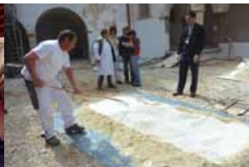
Prikaz klasične metode priprave apnene malte.
